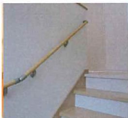
手すりの設置
